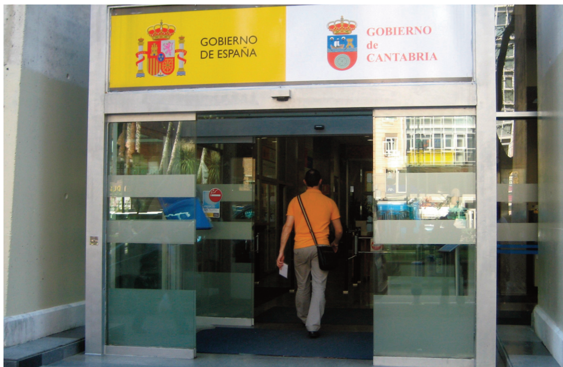
NUEVO ACCESO PUERTA PRINCIPAL.
