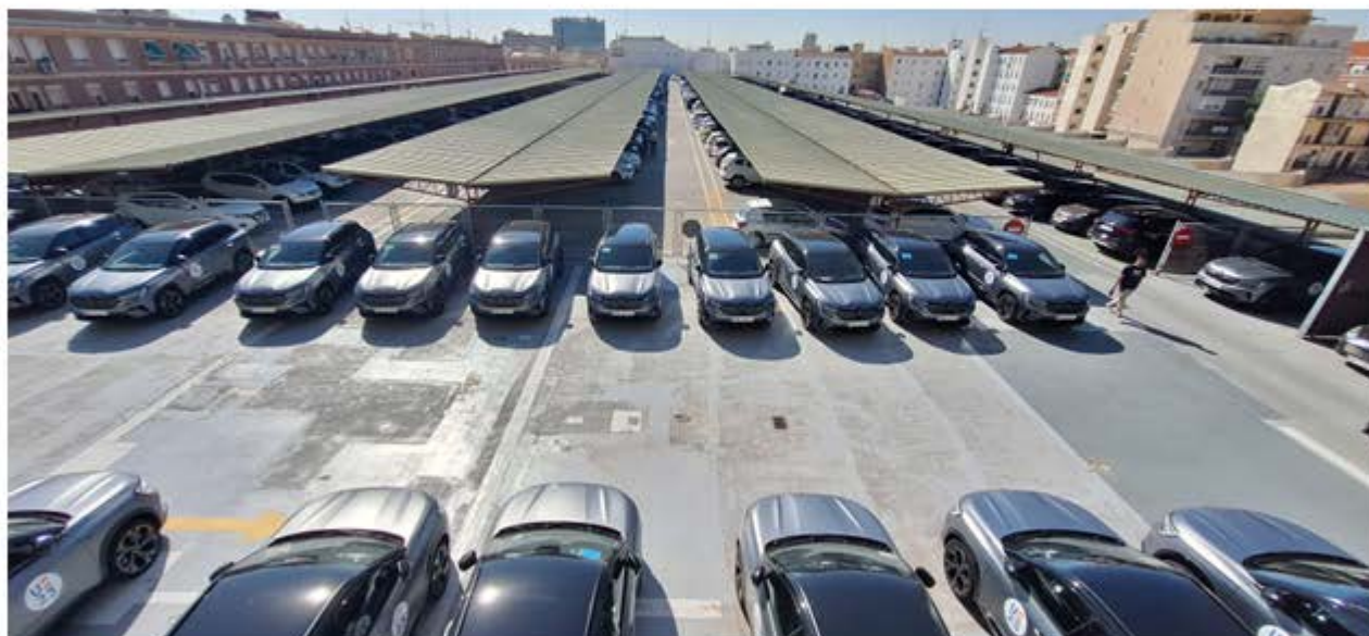
Vista superior de la tercera planta del PMEOA
