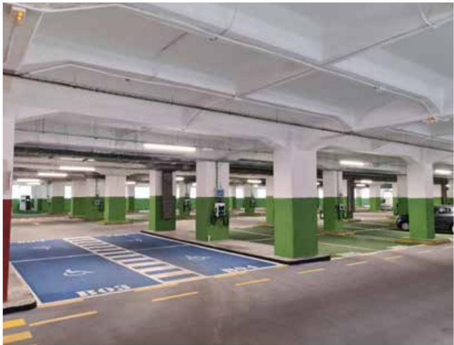
La ejecución de la obra comprendió la demolición y desmontaje de elementos no necesarios para el uso previsto, en particular la retirada de isletas y bordillos delimitadores (existentes desde la construcción del edificio en 1943), para adap-
