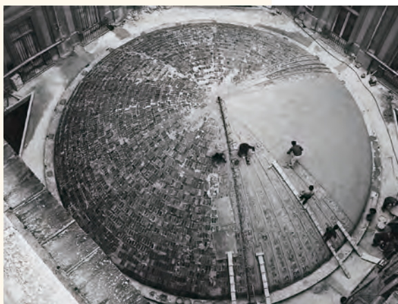
Cúpula en fase de construcción sobre el patio de la Caja General de Depósitos (1963).
