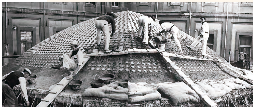
Durante las obras.
