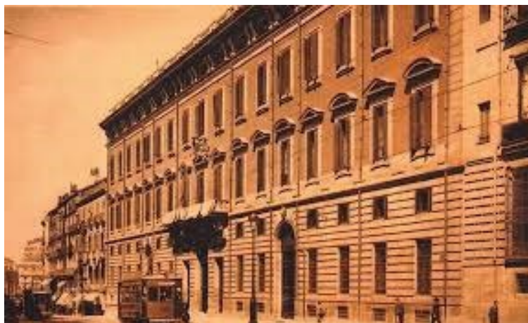
Fachada a finales del Siglo XIX
