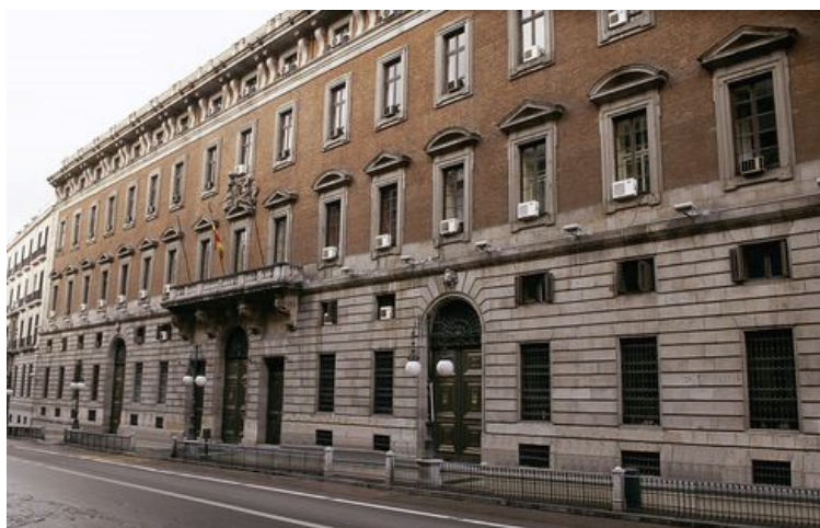
El edificio en la actualidad
